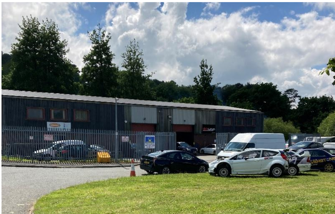
Figure 4.25 Llanfairfechan Industrial Estate, Llanfairfechan.
